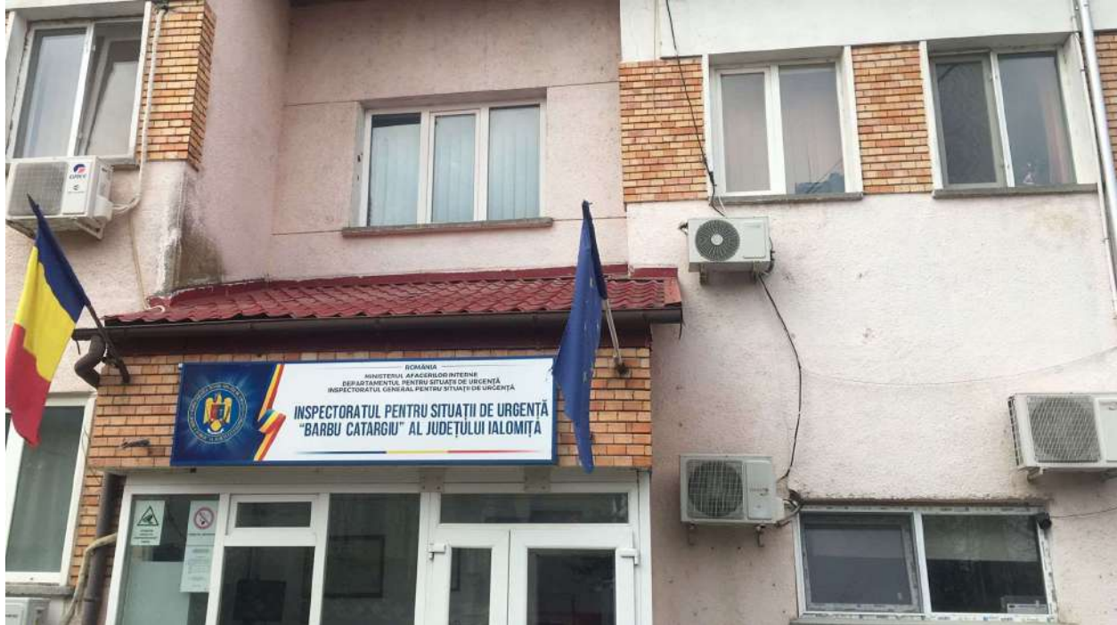
Fig 8 Clădirea administrativă C1 a ISU Slobozia si DPS
